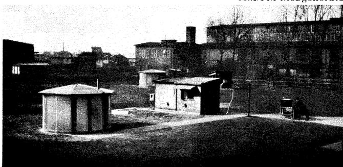
Bild 10. Anlage zur Messung der Störstrahlung von Fernsehempfängern im neuen Telefunken-Gerätewerk
